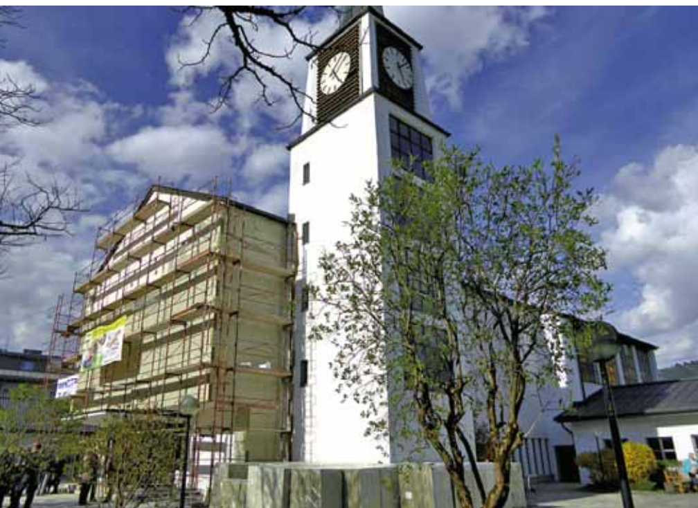
Thermische Außensanierung der Kirche Schüttdorf
