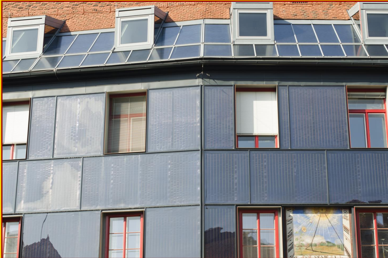
Thermische Solaranlage
