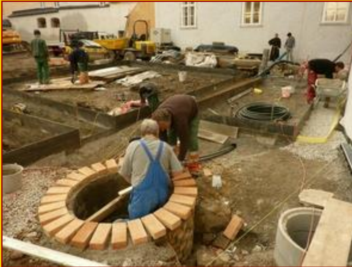
Brunnenbau für die Wärmepumpenanlage
